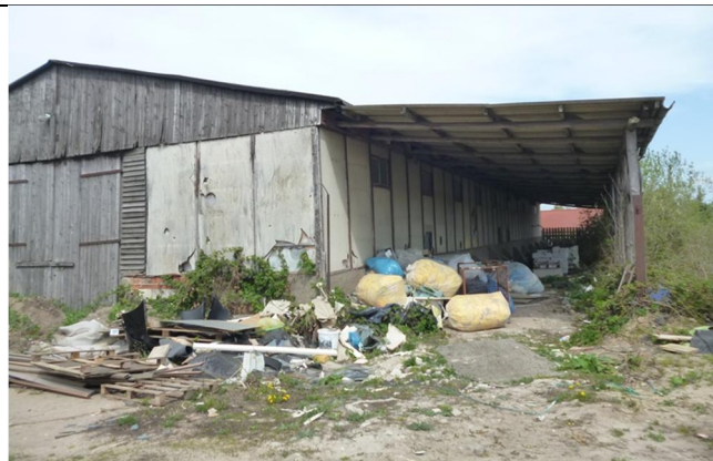
Bild 4: Lagerhalle und Müllablagerungen im NW-Teil des Betriebshofes (© SKH)
