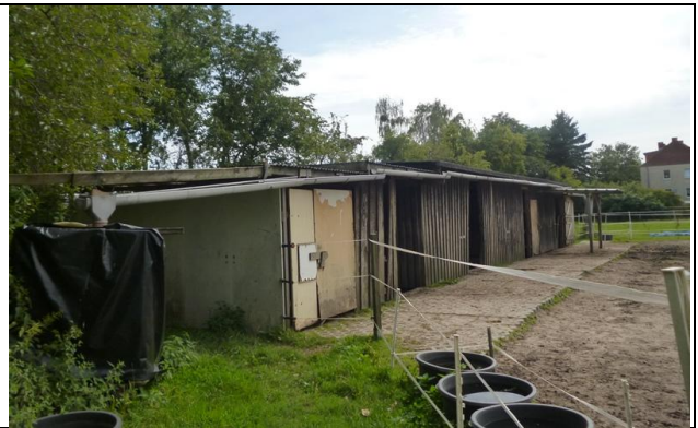
Bild 2: Unterstand für Pferde (Holz, Mauerwerk) - sporadische Nutzung durch Schwalben (© SKH)
