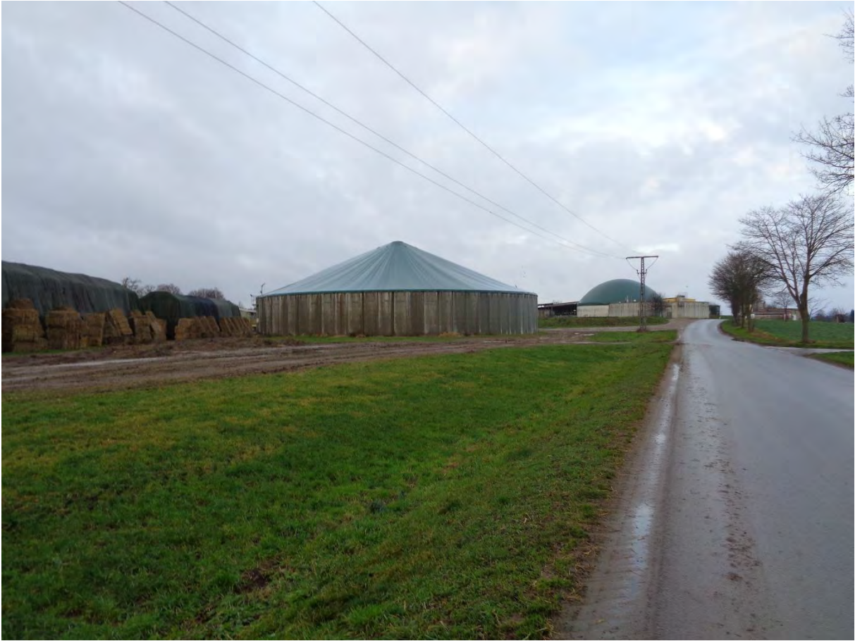
Bild 03 Plangebiet vom Osten
